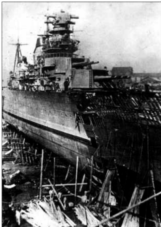
Крейсер «Максим Горький» в сухом доке (идет формирование новой носовой оконечности)
